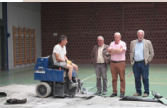
Le début des travaux
