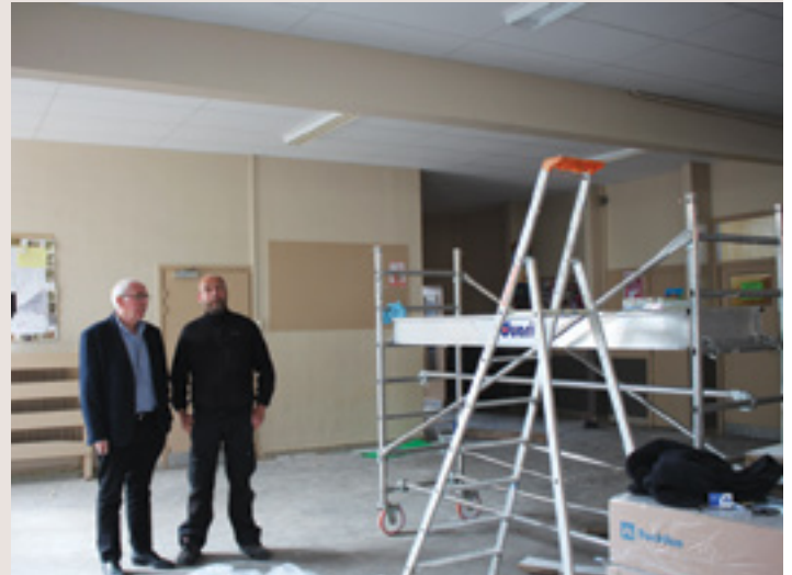
Un plafond refait entièrement...
