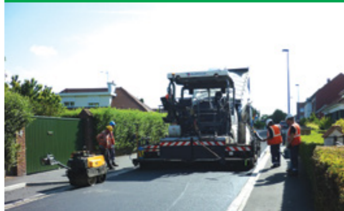
Travaux rue Schweitzer - juin
