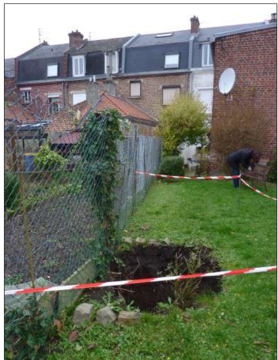
Figure III.20: Débouillage de puits rue Gustave Colin. Source: DDTM62 (ARR220)
