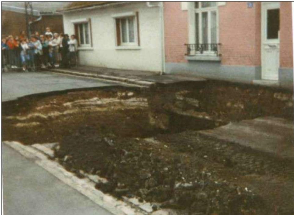
Figure III.14: Fontis à l'avant du 21 rue Victor Hugo à Beaurains. Source : BRGM (BEA25).
